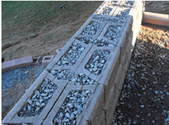
Şakil 8: İçi boş beton blok istinad divarı
