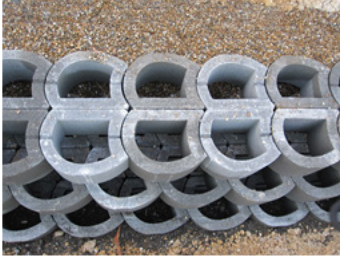
Şekil 4: Dövikli blokdan hazırlanmış istinad divarı
