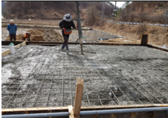
Şəkil 3: Betonun nasoslu maşınla tökülməsi
