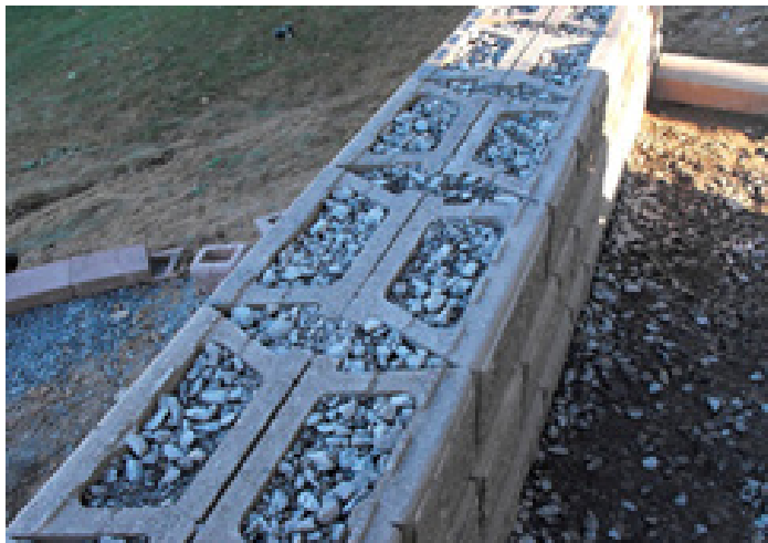
Şakil 10: Boşluqları olan beton bloklardan hazırlanan divar
