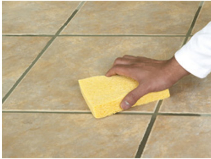
Şəkil 6: Artıq dolğunu təmizləmə
