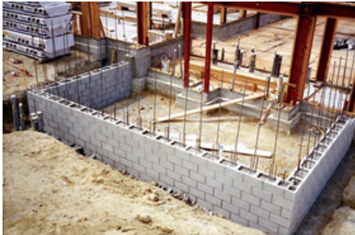
Şəkil 2: Dəmir-beton konstruksiyalı divarın strukturu tikintisi
