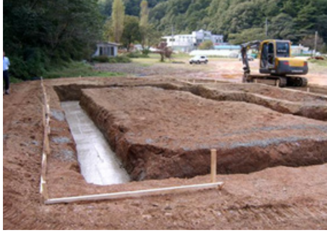
Şəkil 3: Ekskavatorla qazma
