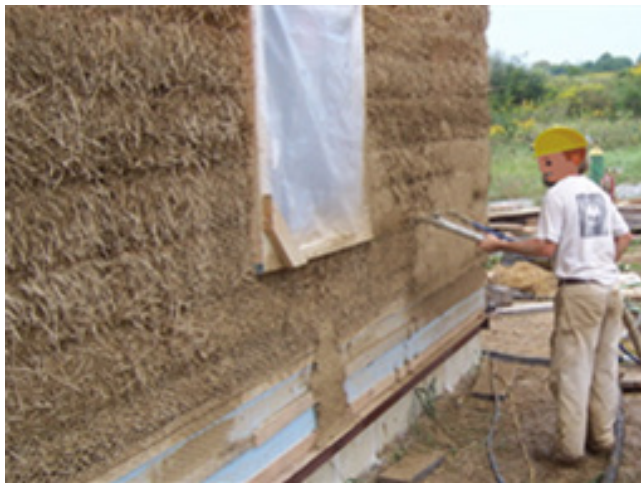
Şəkil 4: Əhəngin püskürdülməsi
