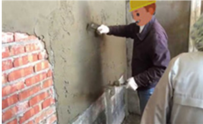
Şəkil 2: Sement məhlulu ilə suvanma (1-ci qat)
