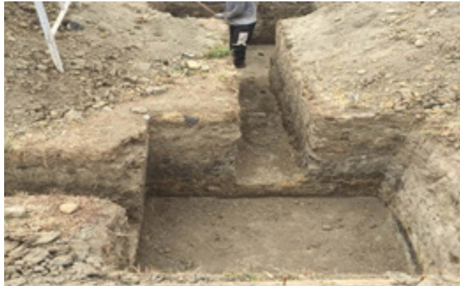
řekil 2: Dayaq  c n z minin qazılması v  dir kl rin basdırılması
