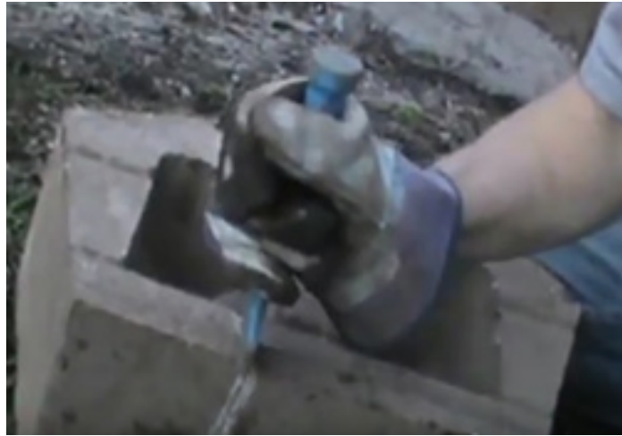
Şəkil 2: İskənə ilə istinad divarının blokunu kəsin
