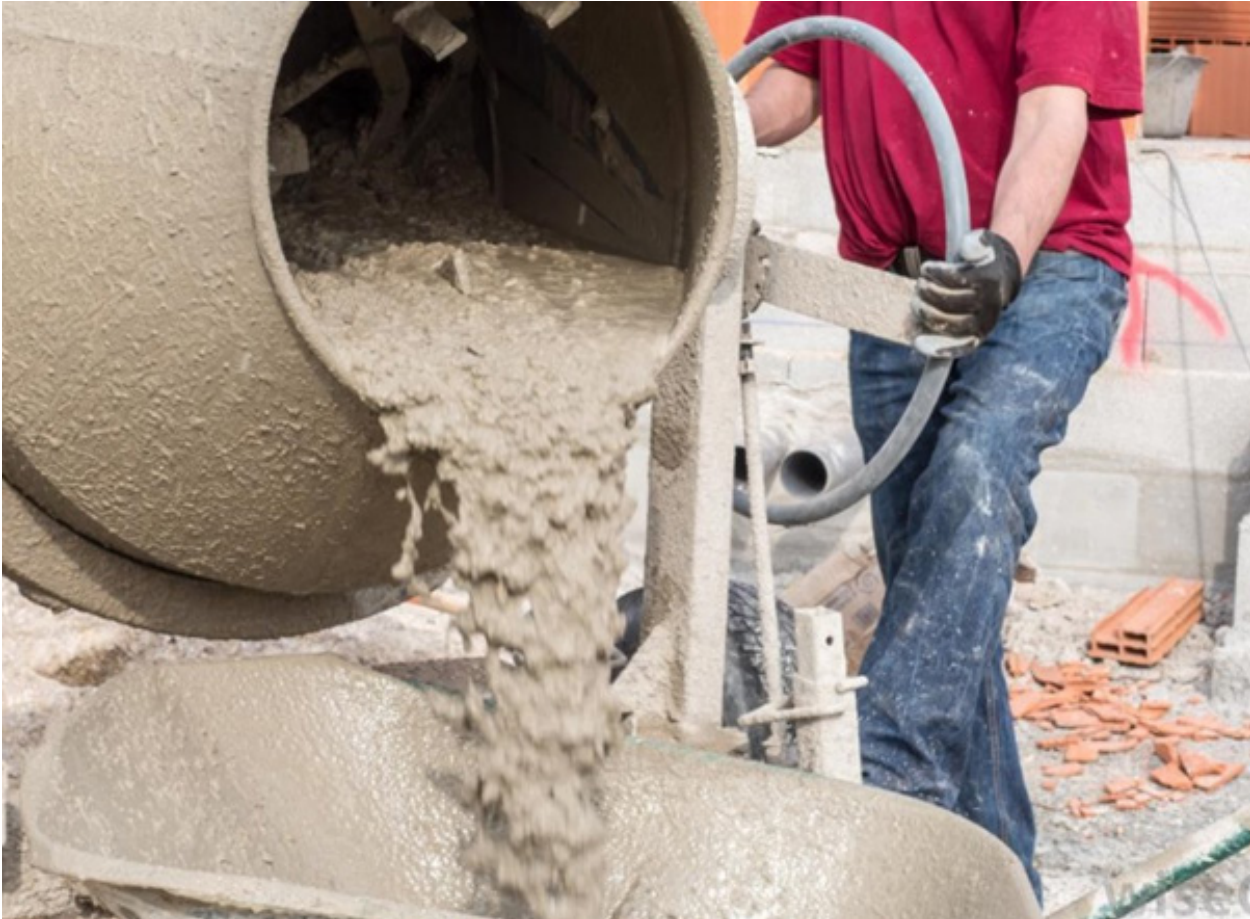
Şəkil 1: Beton qarışığının tökülməsi
