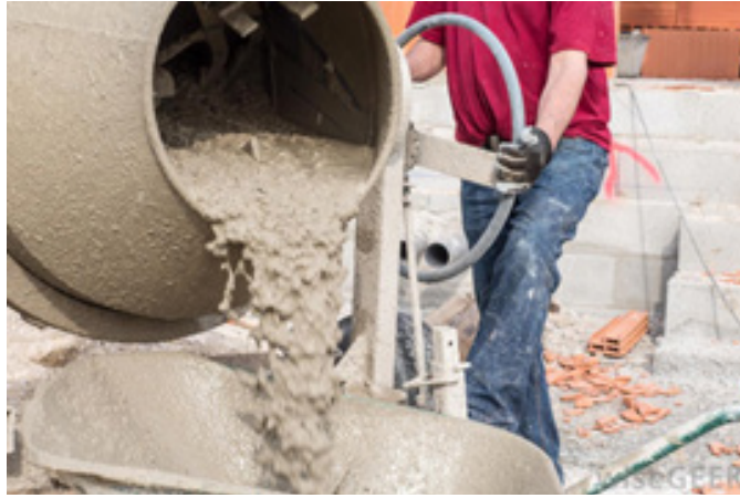
Şəkil 1: Betonqarışdırıcı maşın
