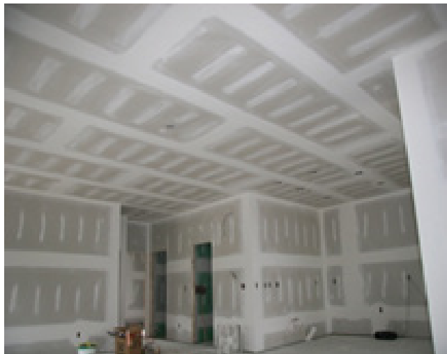
Şəkil 1: Alçıpanın hazır vəziyyətə gəlməsi
