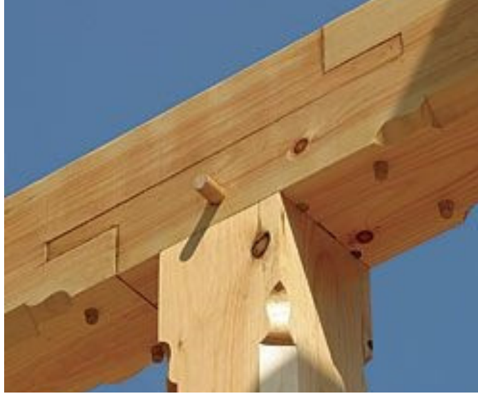
Şəkil 1: Sütunda çıxıntılı şərf birləşmə
