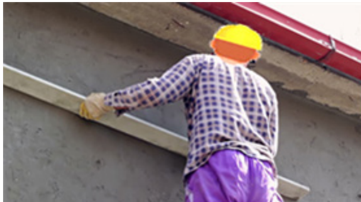
Şəkil 7: Çərçivə qəlib taxtası ilə hamarlaşma
