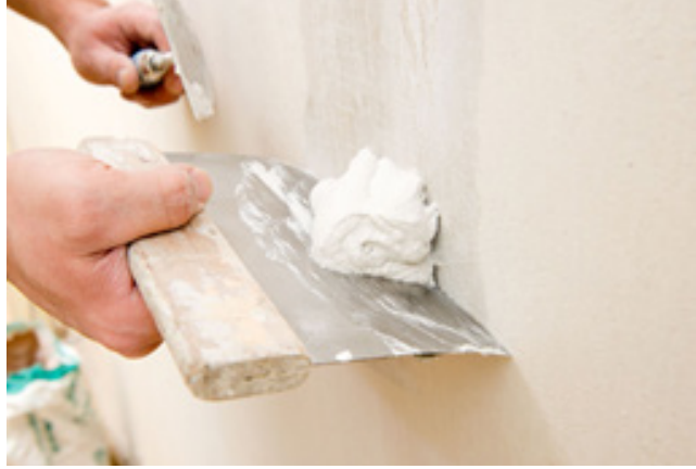
Şəkil 2: Nahamar səthin üzlük qat çəkməklə hamarlaşdırılması
