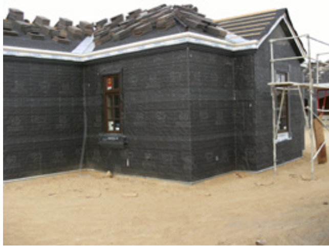
Şəkil 3: Suvaq üçün məftil
