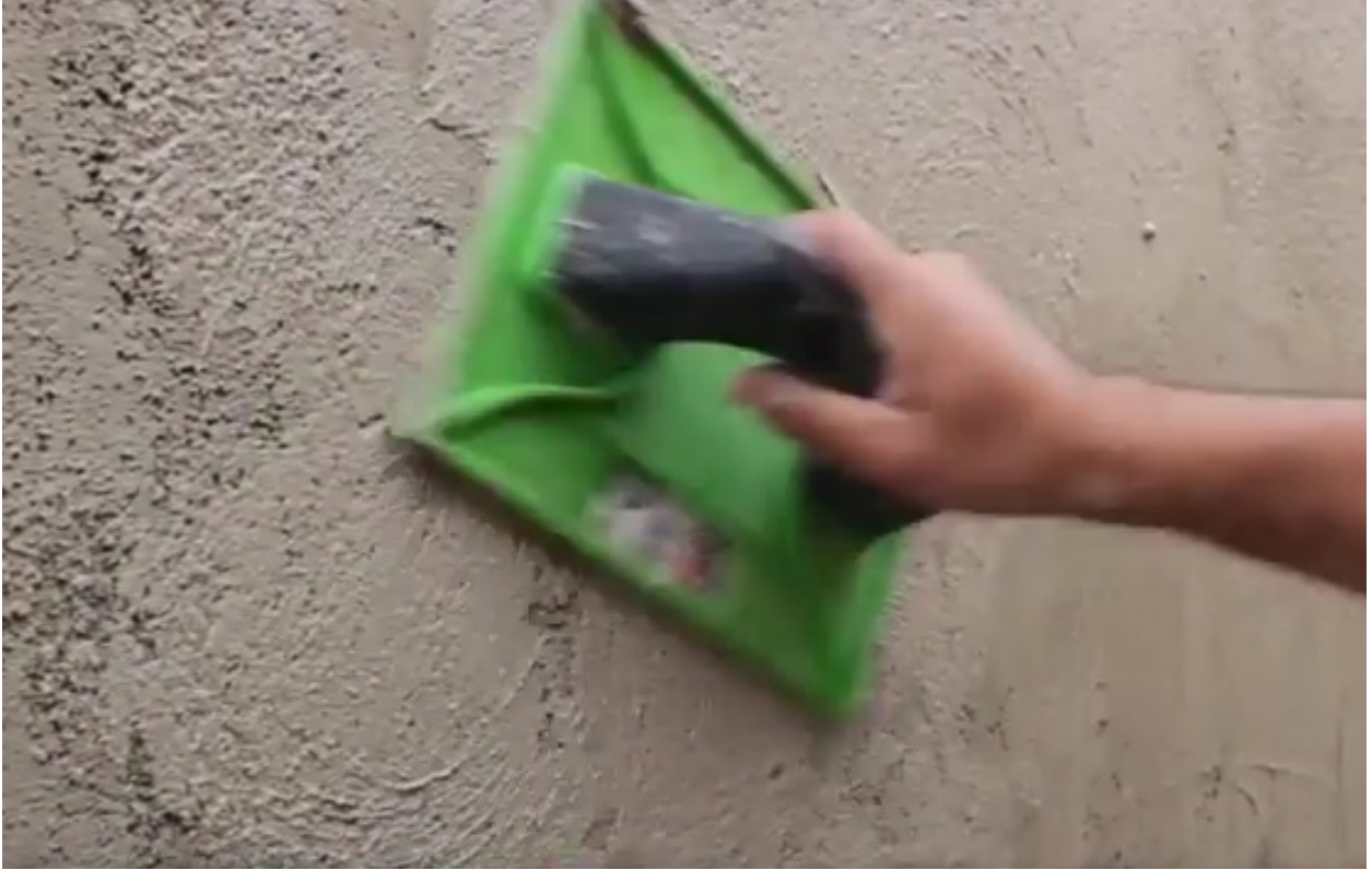
Şəkil 1: Beton divarın sement qatqısı ilə suvanması
