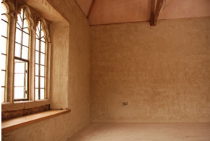
Şəkil 3: Gips əsaslı suvaq
