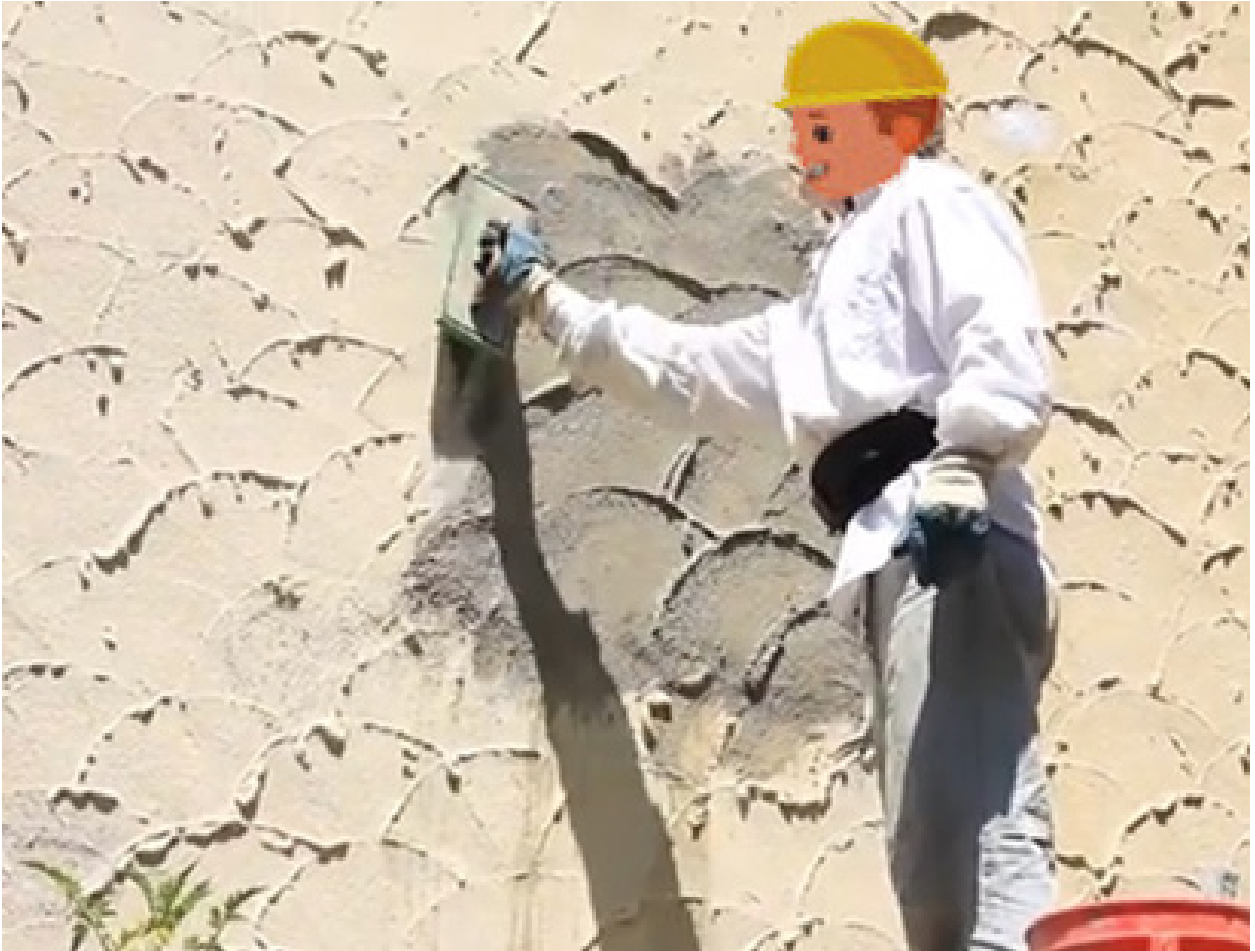
Şəkil 1: Stükko (suvaq) qatqısının divara suvanması
