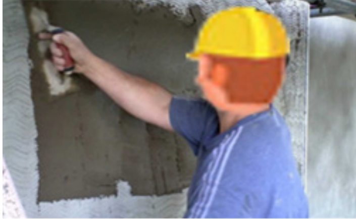
Şəkil 8: Suvağın çəkilməsi (ikinci üzlük)
