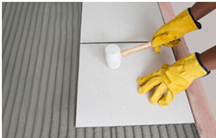
Şəkil 3: Sement əsaslı kafel yapışdırıcı ilə kafelin düzülməsi
