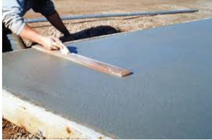
Şəkil 3: Uzun mala ilə səthin hamarlaşdırılması
