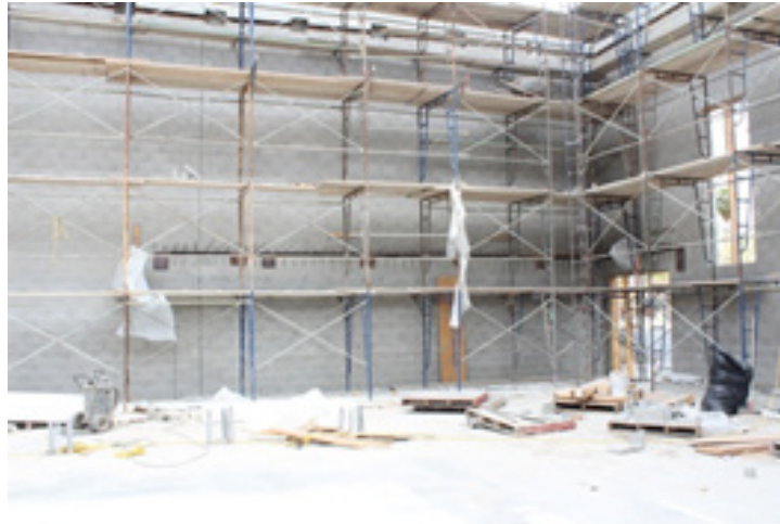
Şəkil 12: Yüksək CMU divarı
