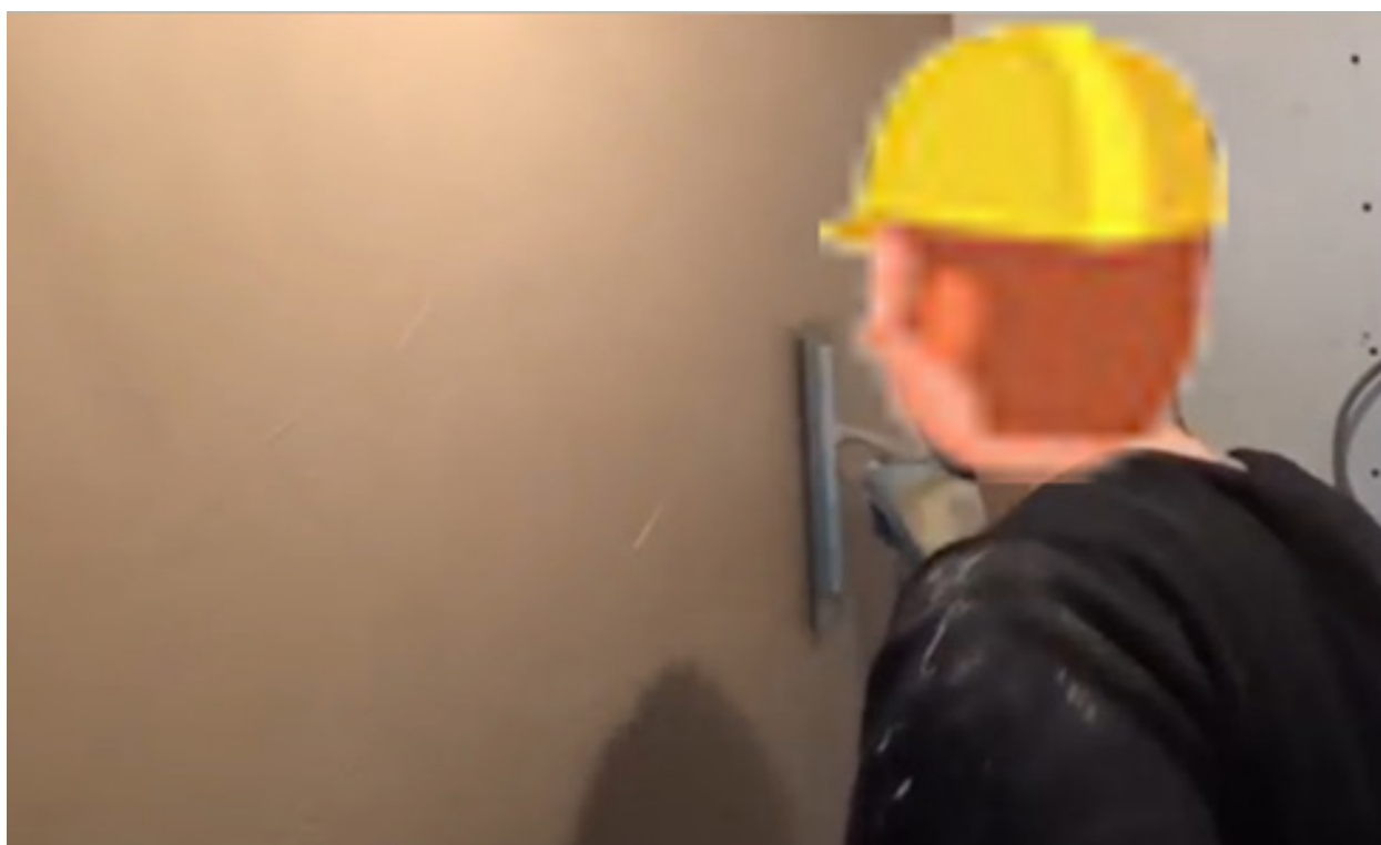
Şəkil 1: Beton divara suvağın çəkilməsi
