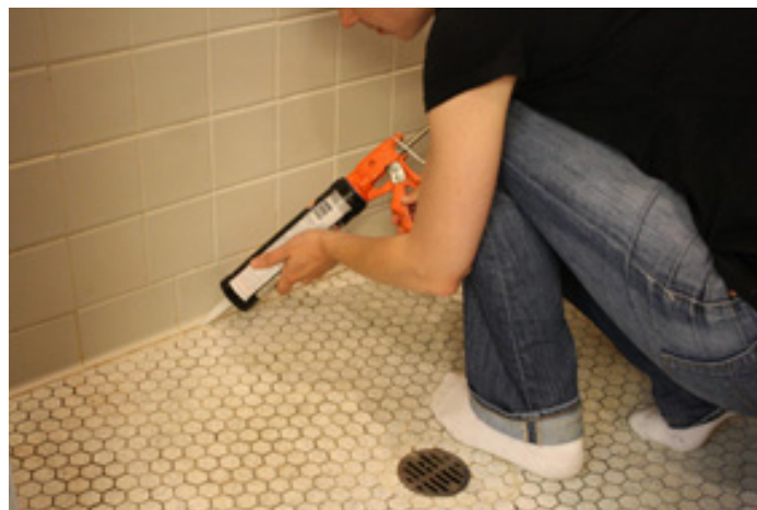
Şəkil 4: Yeni suvağı çəkin
