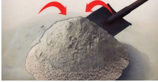
Şəkil 5: Kürəklə sementin quma qarışdırılması
