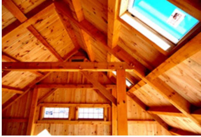
Şəkil 3: Adi birləşmədən qurulmuş dam
