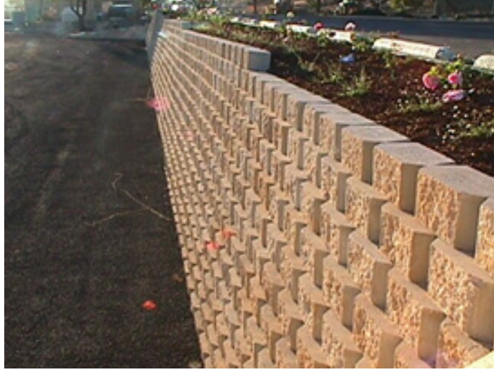
Şakil 7: Almaz formalı beton blok istinad divarı
