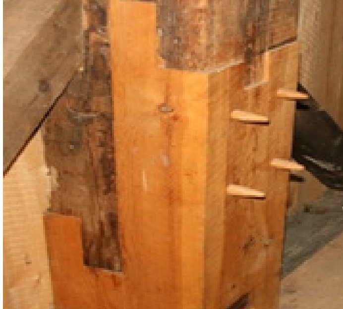
Şəkil 2: Düz hissədə çıxıntılı şərf birləşmə
