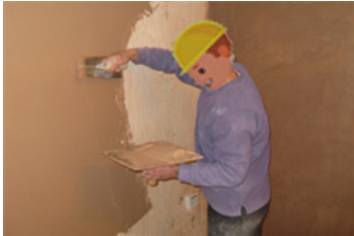
Şəkil 3: Mala və suvaq taxtası ilə suvamaq
