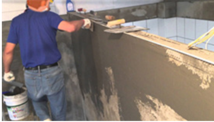
Şəkil 1: Sement qarışığı ilə suvanma (2-ci qat)
