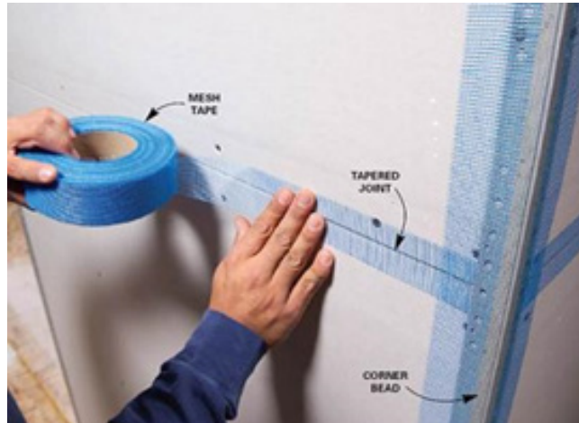
Şəkil 3: Alçıpanda ilgək lentinin istifadəsi
