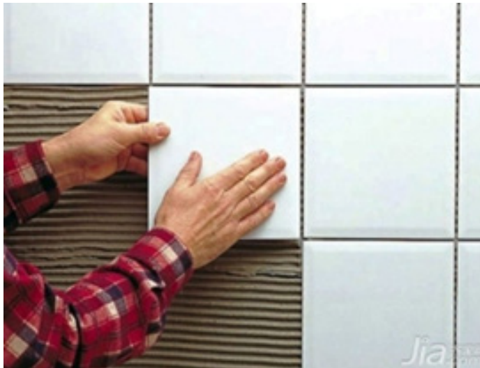
Şəkil 1: Sement əsaslı divar kafel yapışdırıcı
