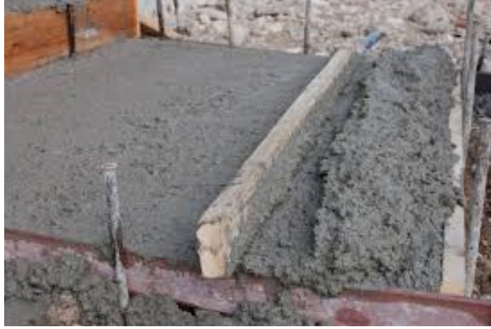
Şəkil 1: Düz taxta ilə əhatələnmiş çərçivə qəlib
