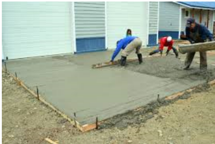
Şəkil 2: Beton səki üzərində çərçivə qəlib
