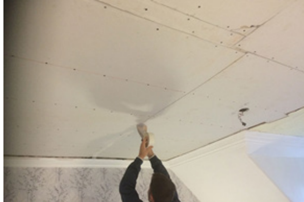
Şəkil 3: Tavan aralığına lentin tətbiqi
