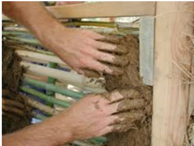
Şəkil 8: Bambuk vatlının palçıqla suvanması
