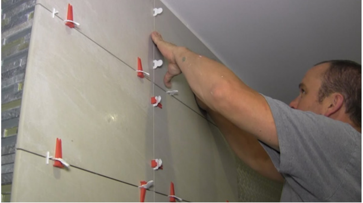
Şəkil 1: Sadə divara kafelin vurulması
