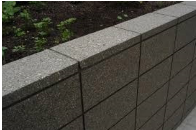
Şəkil 5: Tayalanmış bloklardan hazırlanan divar
