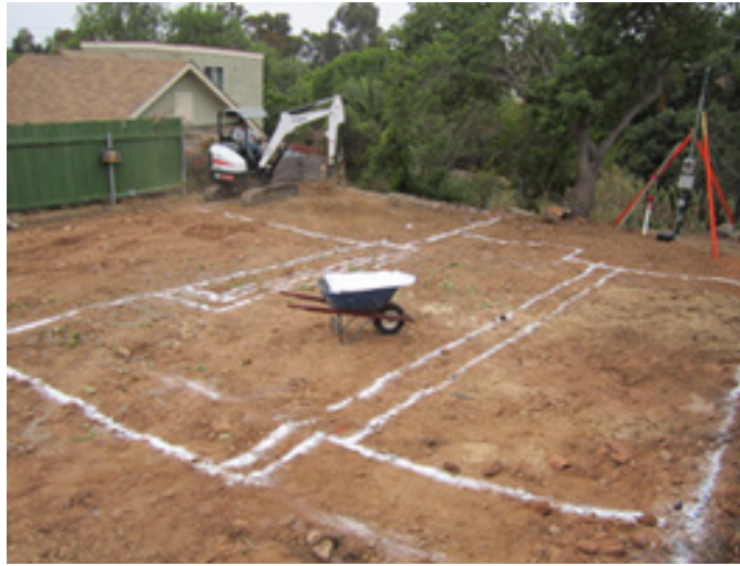
Şəkil 4: Ağ əhəng tozu ilə xətlərin çəkilməsi
