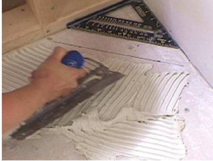
Şəkil 4: Kafelin diaqonal şəkildə qoyulması
