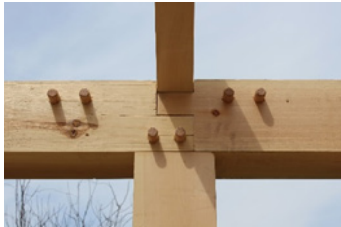
Şəkil 9: Qərb dülgərliyində çarpaz formalı birləşdirici
