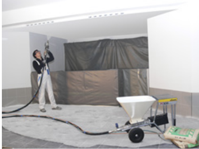
Şəkil 2: İnşaat məhlulunun püskürdülması
