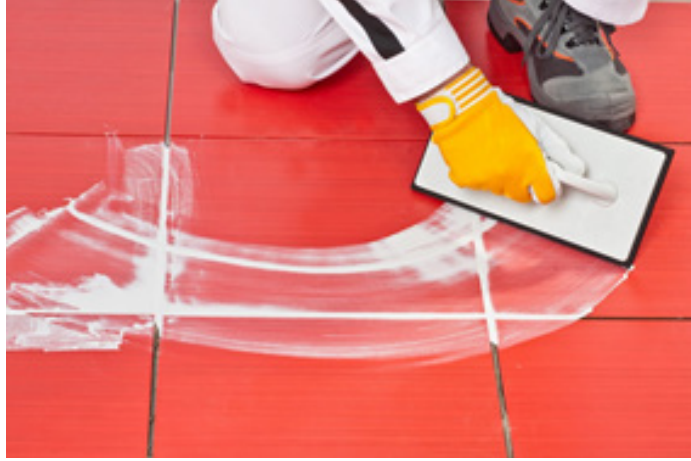
Şəkil 5: Döşəmə kafeli doldurma
