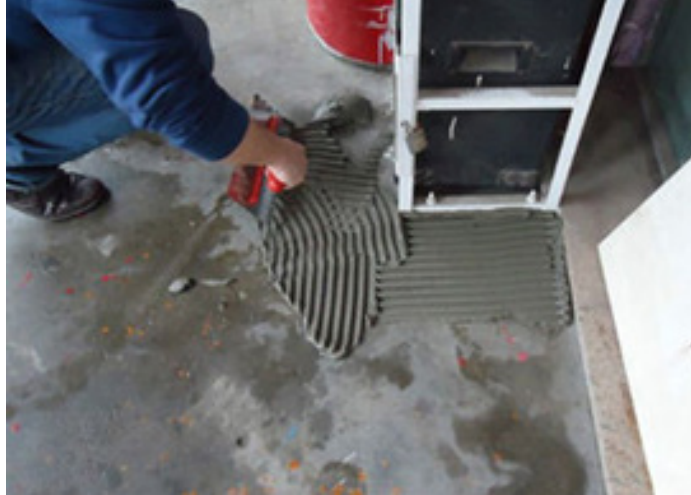
Şəkil 2: Sement əsaslı kafel yapışdırıcı
