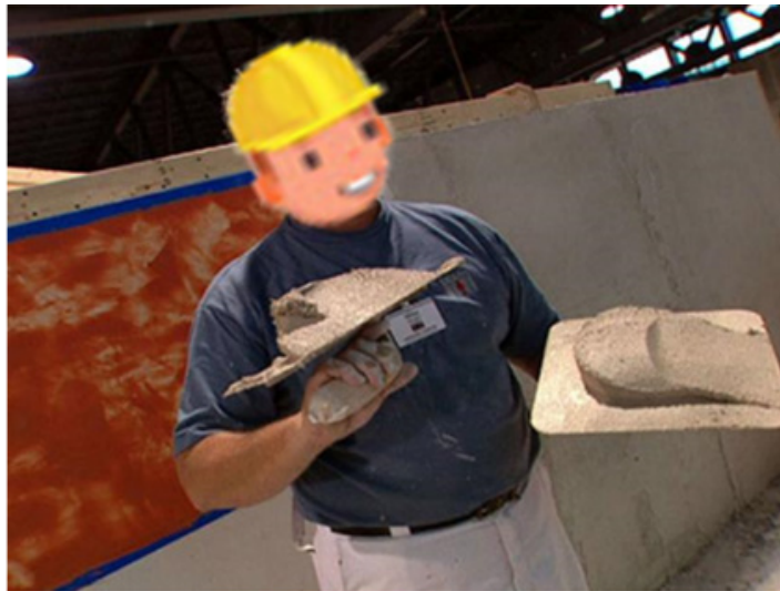
Şəkil 5: Suvaq taxtasının və malanın əldə düzgün tutulma qaydası
