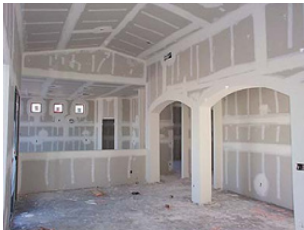
Şəkil 4: Aralıqları lətlənmiş gips-karton
