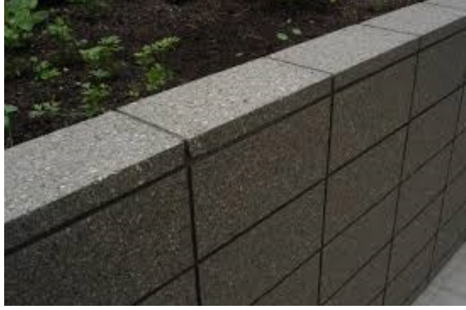
Şəkil 5: Tayalanmış bloklardan hazırlanan divar
