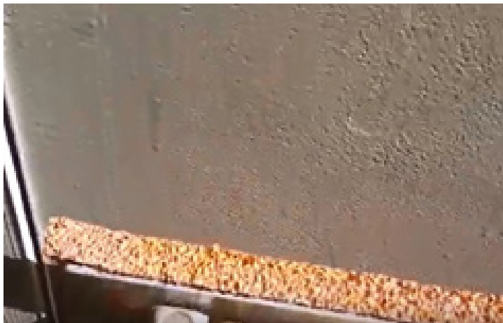
Şəkil 10: Süngər malayla səthin hamarlaşdırılması
