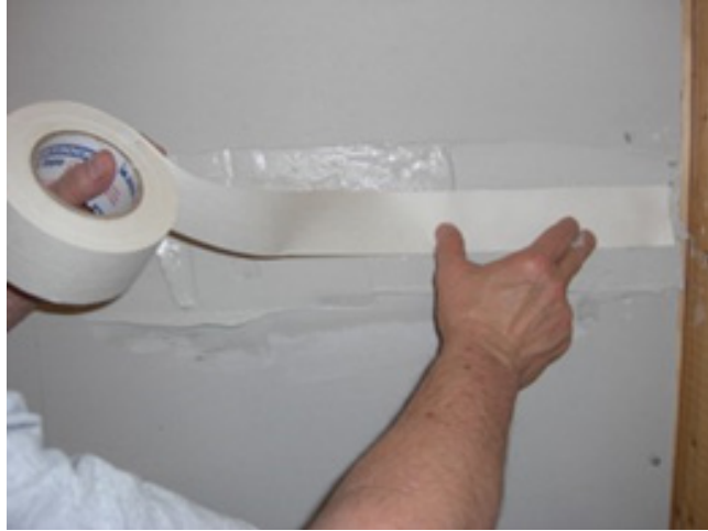
Şəkil 4: Kağız lentin alçıpana yerləşdirilməsi
