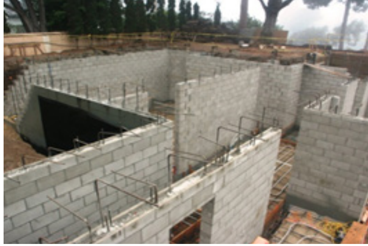
Şəkil 11: Armaturlanmış CMU divarı
