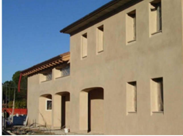
Şəkil 2: Fasadın əhəng ilə suvanması
