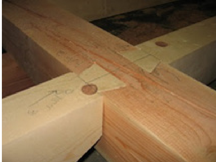
Şəkil 4: Qaranquş quyruğu formalı birləşməsində üfüqi birləşmə (tir)
