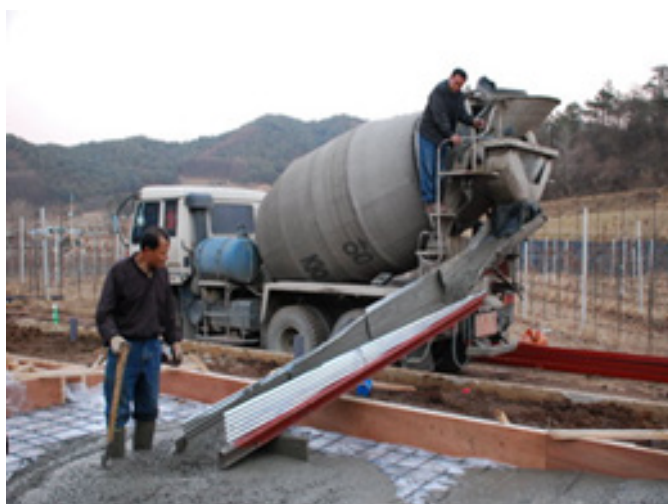
Şəkil 4: Betonun maşınla tökülməsi
