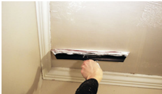
Şəkil 1: Tavana üzlük qatın çəkilməsi
